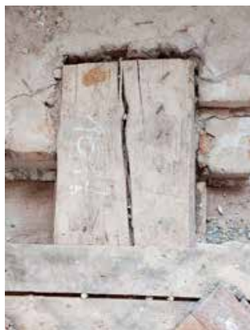
Zeitzeugnisse: Bei den Voruntersuchungen kamen jahrhundertalte Holzbalken zum Vorschein – einige stammen noch aus dem 16. Jahrhundert und sind dank der kontinuierlichen Nutzung des Gebäudes in erstaunlich gutem Zustand.
