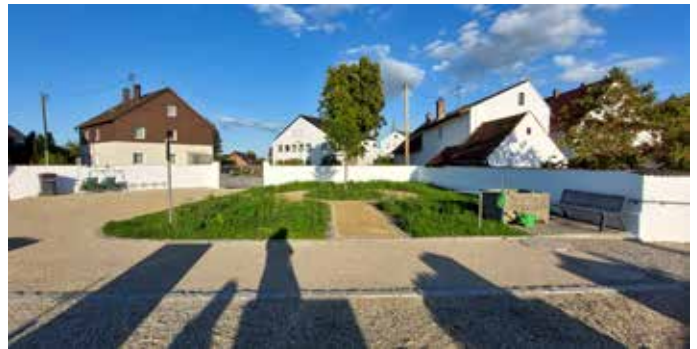
Hier werden die neuen Urnen-Erdröhren auf dem Friedhof in Reichertshofen untergebracht – 26 Stück werden künftig als zusätzliche Bestattungsform zur Verfügung stehen.
