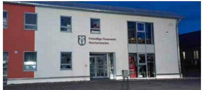
Das Feuerwehrhaus in Reichertshofen soll im Katastrophenfall als notstromversorgter Stützpunkt dienen. Ein mobiles Aggregat mit 100 kVA Leistung ist vorgesehen.
