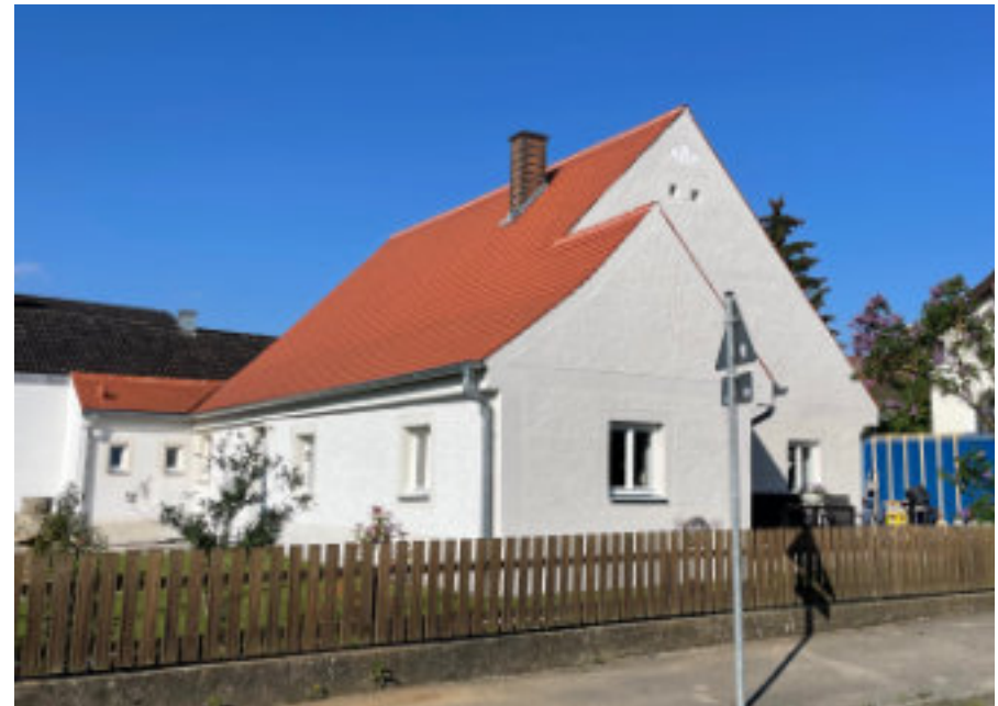
Saniert im Jahr 2024
