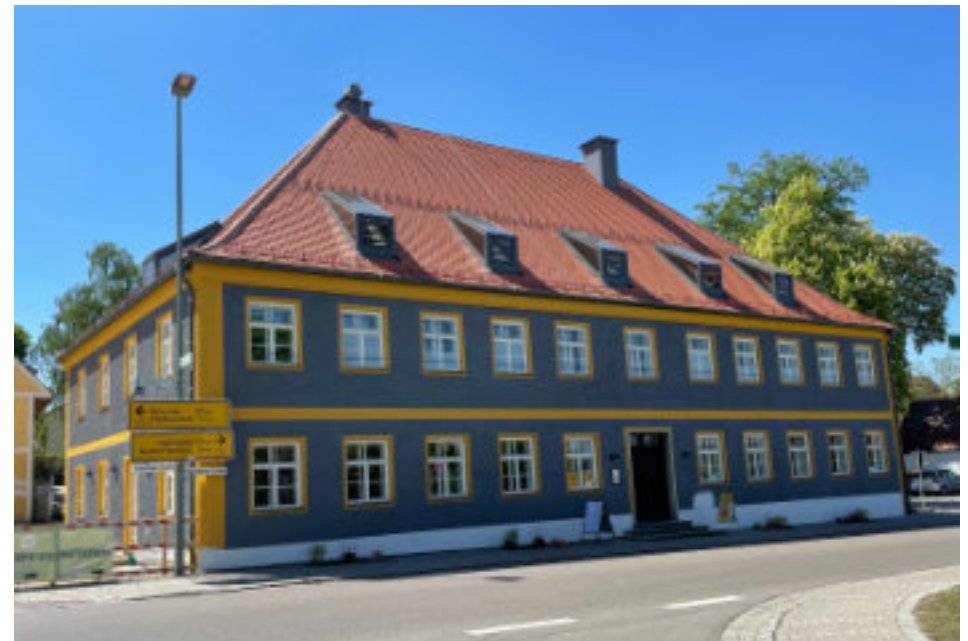
Ehem. Gasthaus zur Post; saniert im Jahr 2024; in der angepassten ursprünglichen Farbgebung.
