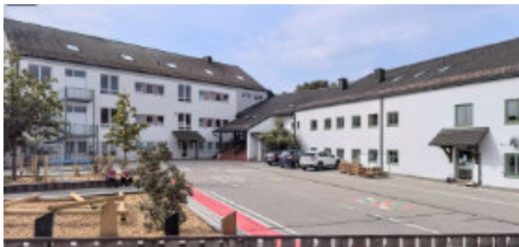
Grundschule in Pörsbach *
